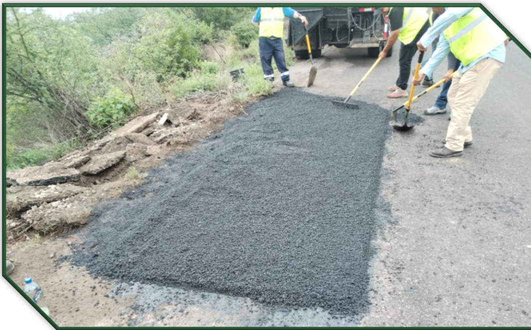
Rehabilitación de la carretera Mezquital-Charcos con Bacheo.
