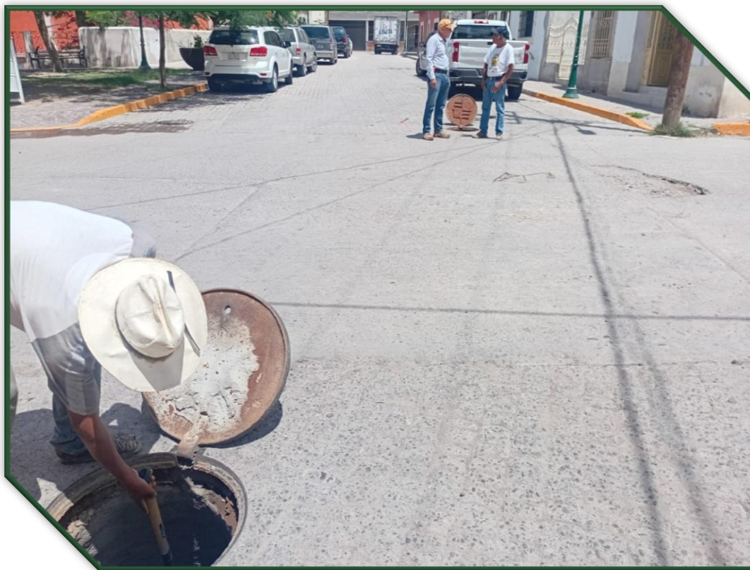
Desazolve de pozo de visita de la calle Principal.
