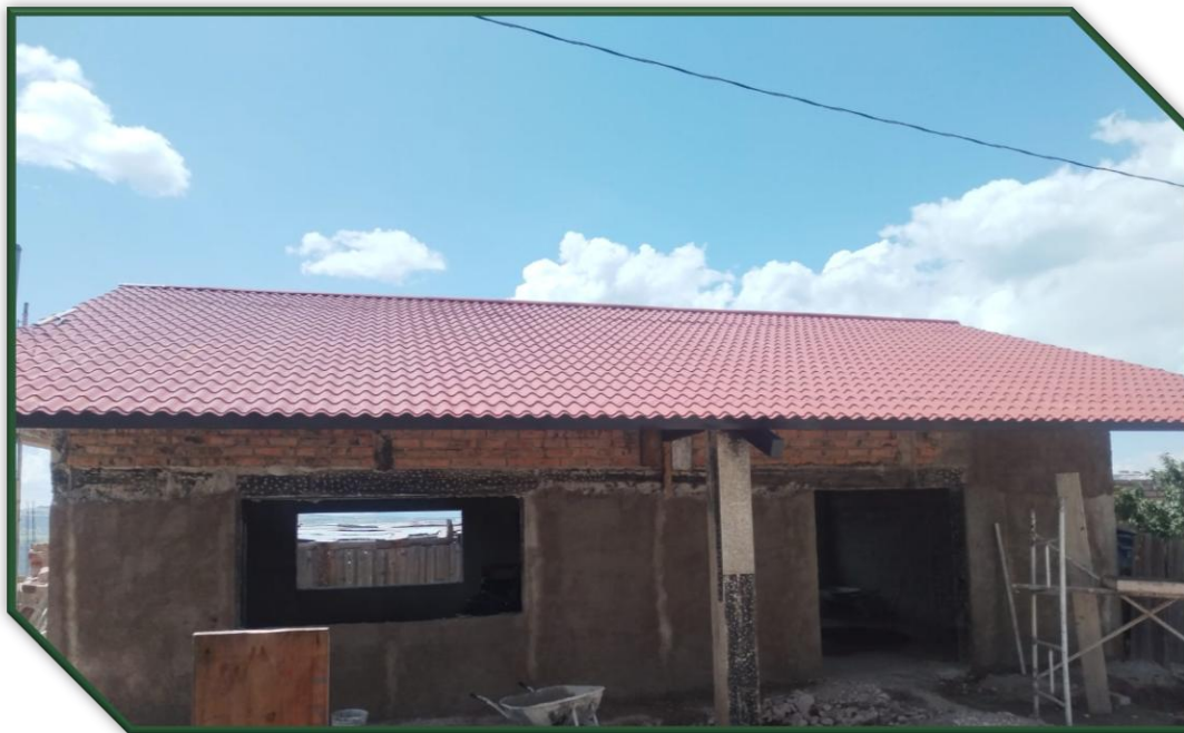
Rehabilitación de oficina comunitaria en Mesa de las Vacas.
