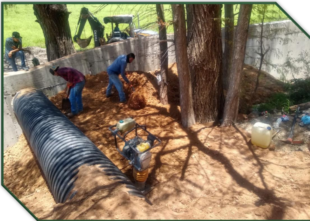
Construcción de libramiento de la calle Hidalgo en San Francisco del Mezquital.
