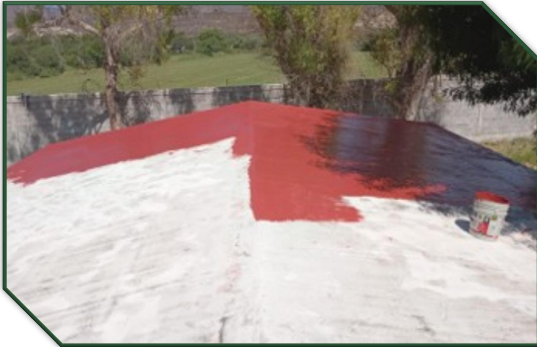
Impermeabilización del albergue de estudiantes.
