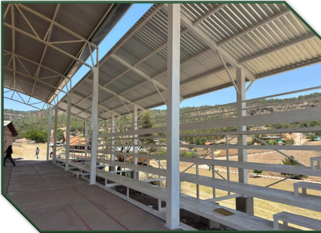
Construcción de gradas e iluminación en cancha pública en San Francisco de Ocotán.
