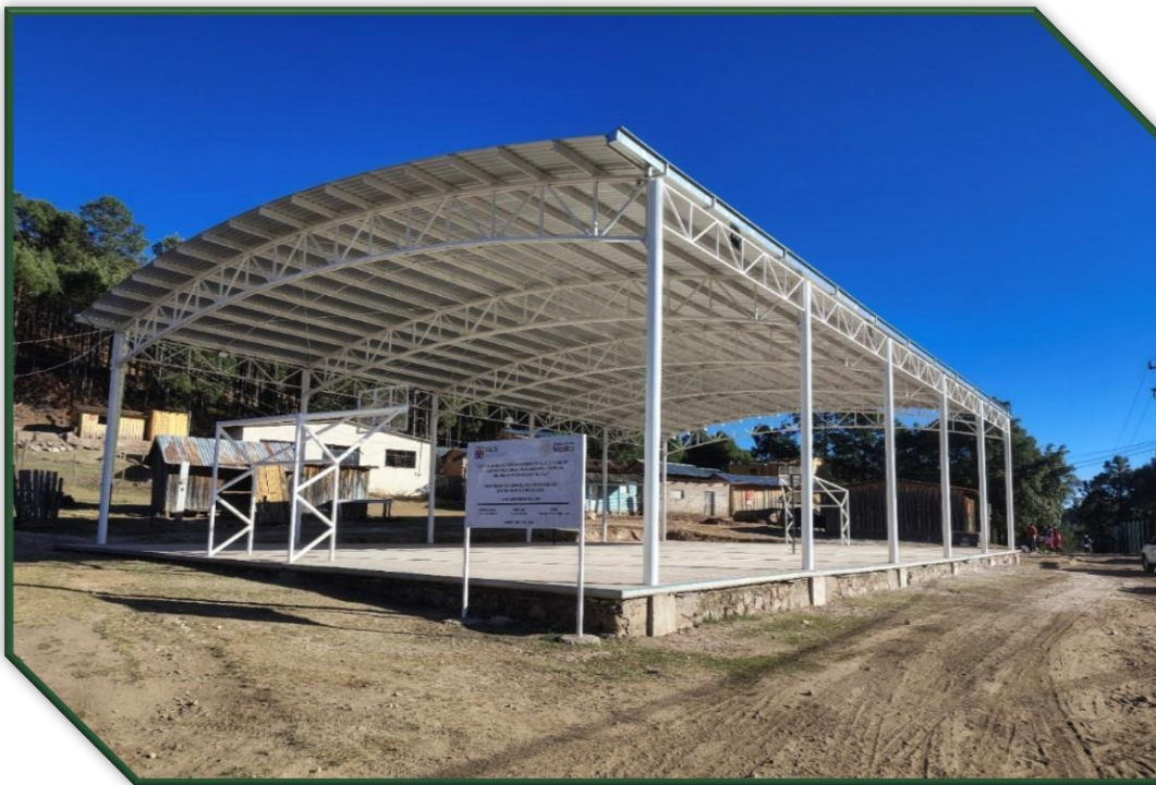
Construcción de cancha y domo en El Chapulín.
