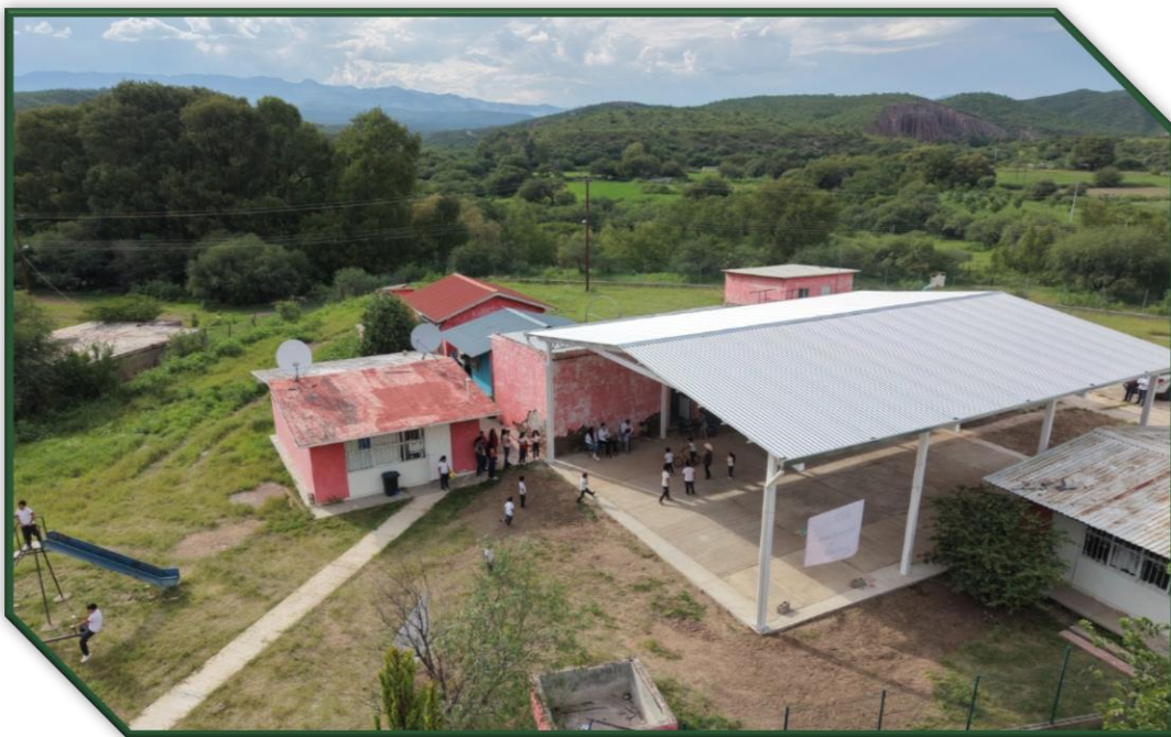
Construcción de techo domo en escuela Primaria "20 De Noviembre" en La Joya de Atotonilco.
