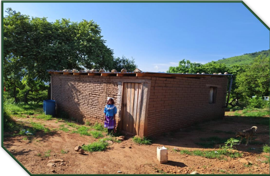
Construcción de techo firme con lámina galvanizada en Huazamotita.
