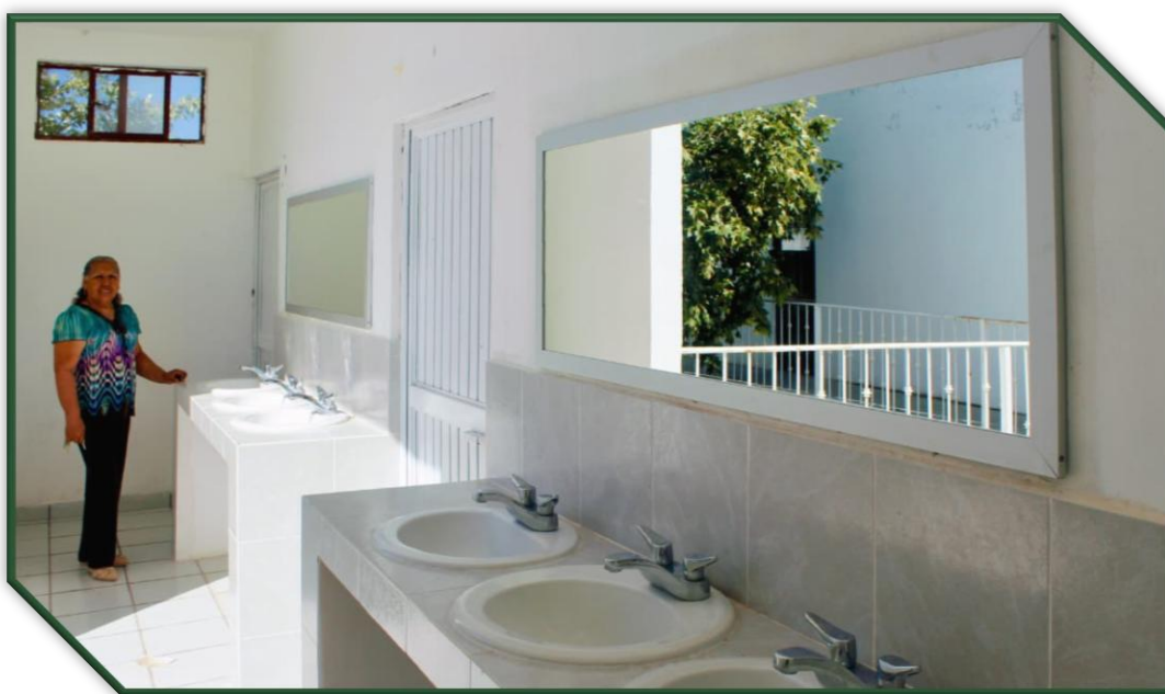
Rehabilitación de los baños del Albergue de Jornaleros.
