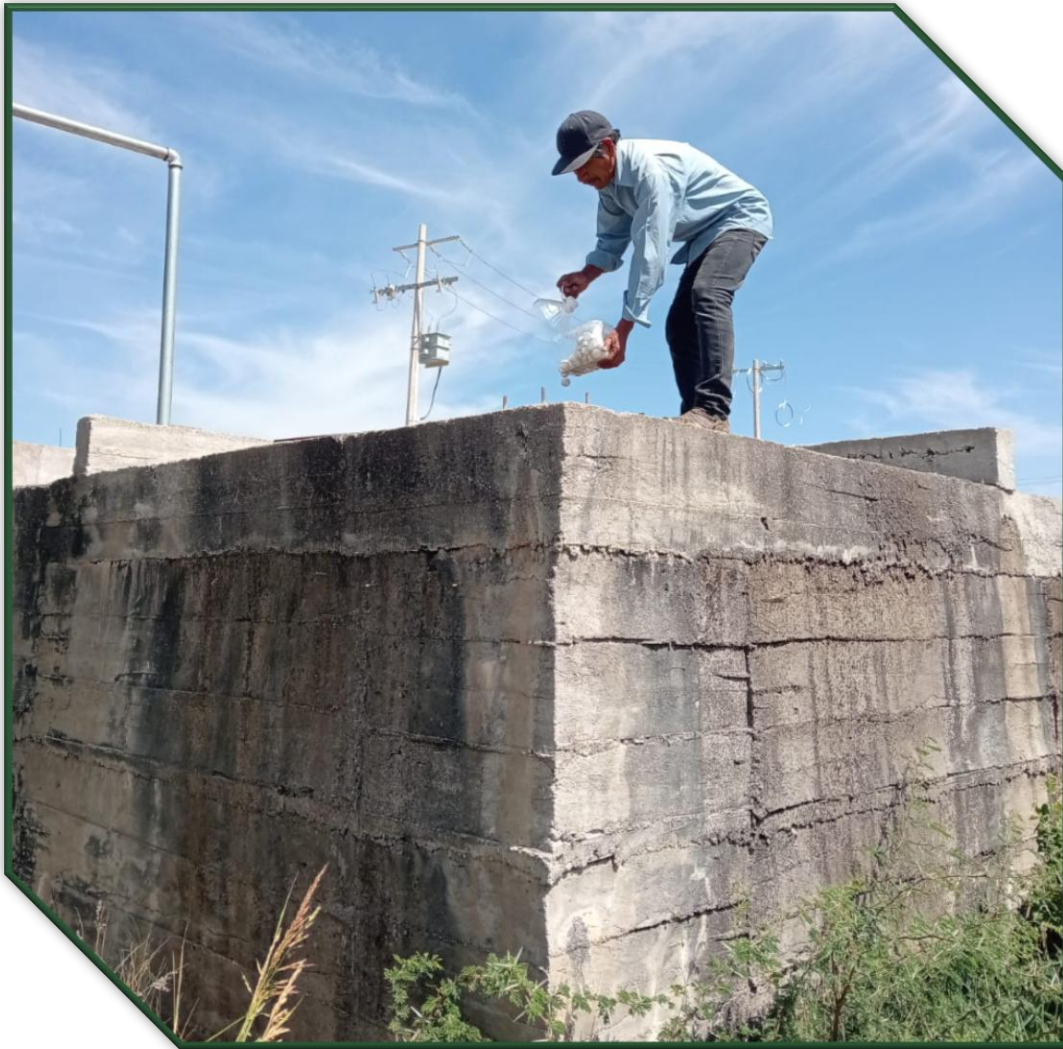
Cloración de agua en tanque.
