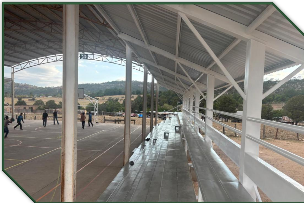
Construcción de gradas e iluminación en cancha pública en Llano Grande.
