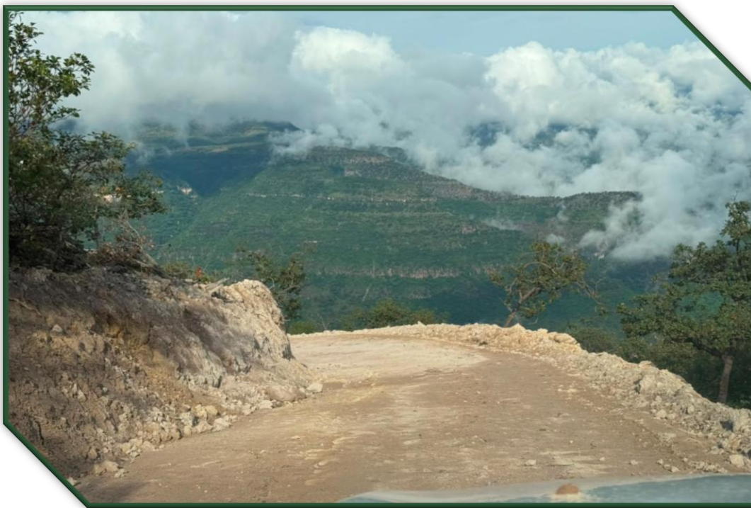
Rehabilitación de camino de Botijas hacia Cihuacora.
