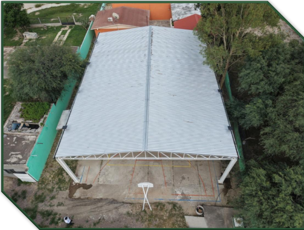
Construcción de techo domo en escuela Primaria "Nicolas Bravo" en El Refugio.
