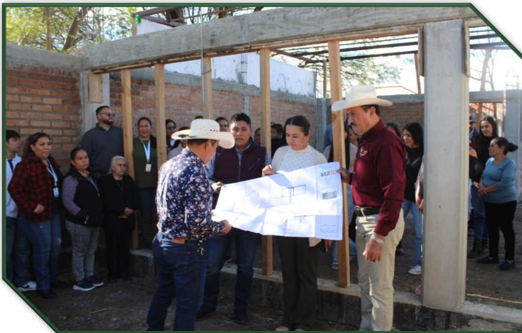
Arranque de obra del comedor DIF.
