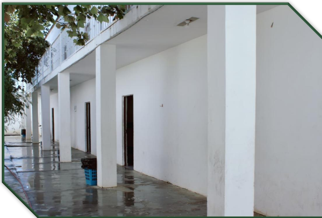
Mantenimiento constante de las instalaciones del Albergue de Jornaleros.
