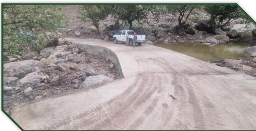
Rehabilitación de camino de Latas hacia La Laguna.
