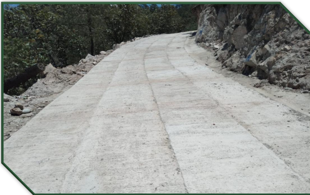
Construcción de pavimento en pendientes críticas de Agüita Zarca hacia Las Milpas.
