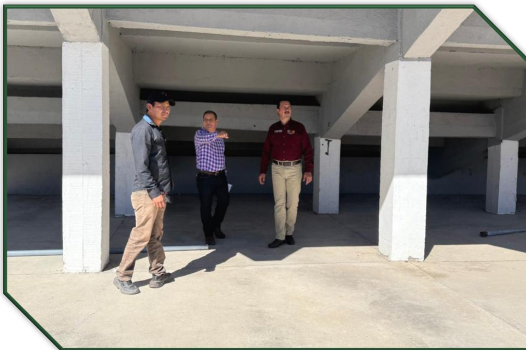
Supervisión de trabajos de la unidad deportiva.
