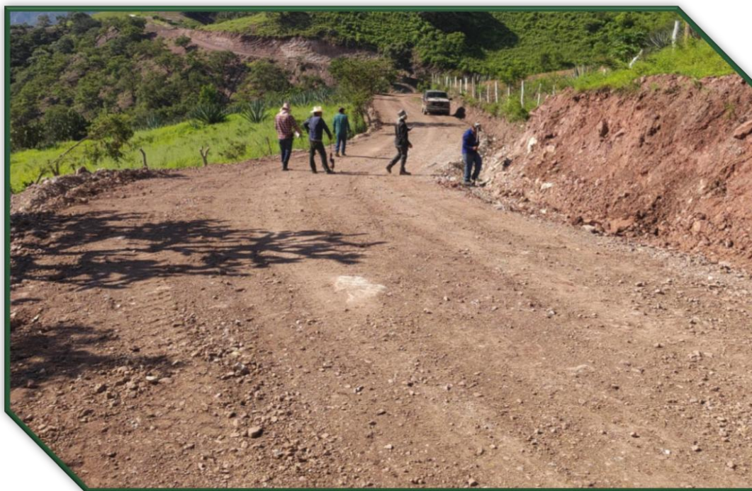
Rehabilitación de camino de terracería de Pinitos - La Laguna del Burro.
