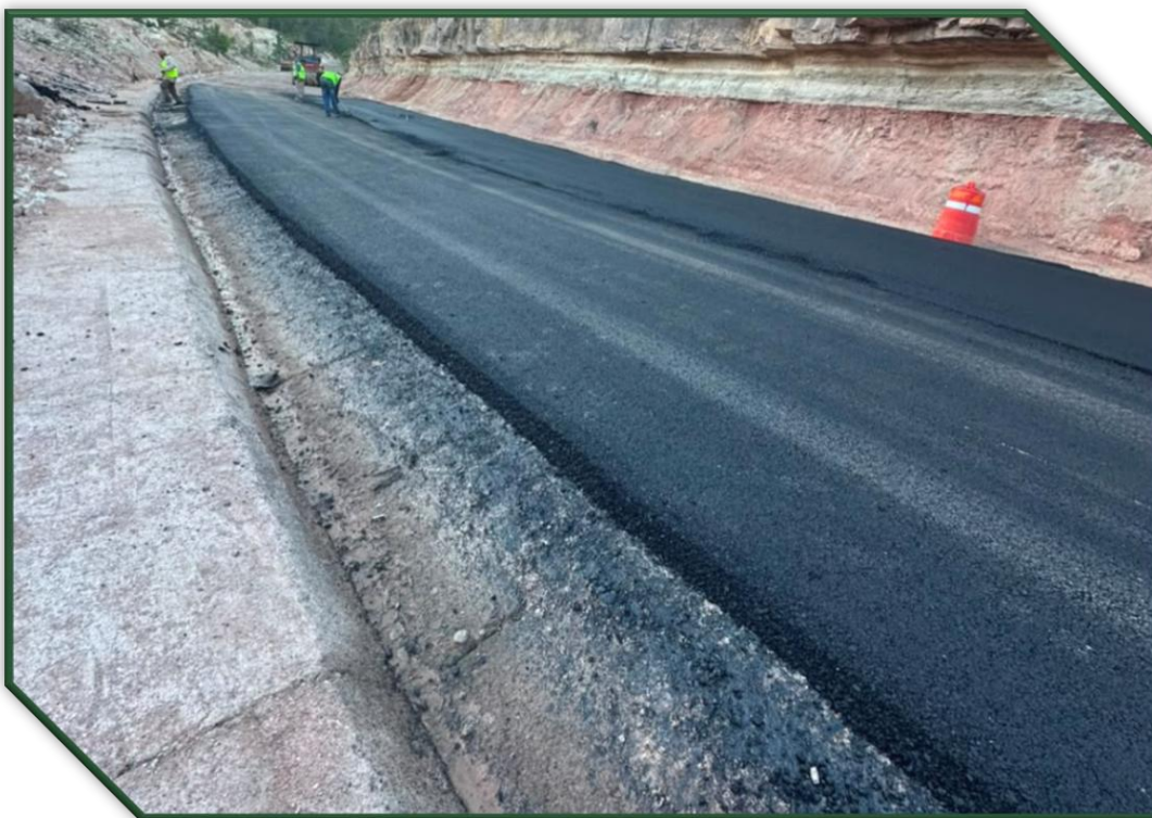
Rehabilitación de carretera de La Guajolota - Santa María de Ocotan.
