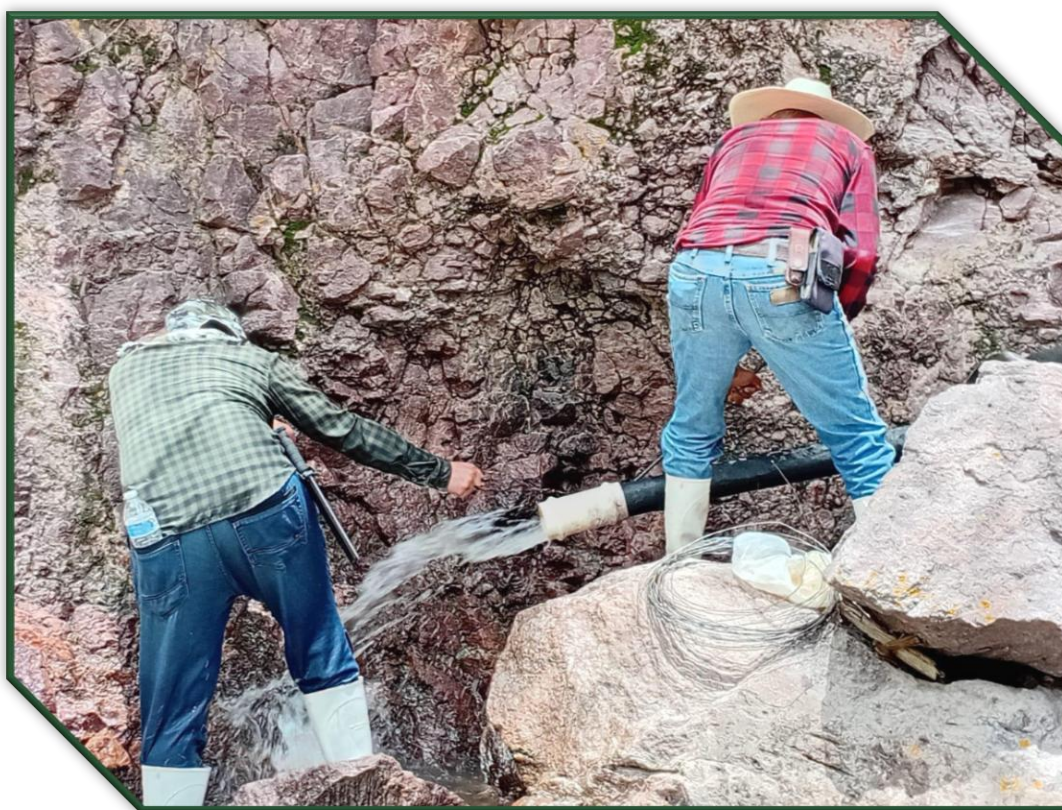
Reparación de fuga en red de agua potable.
