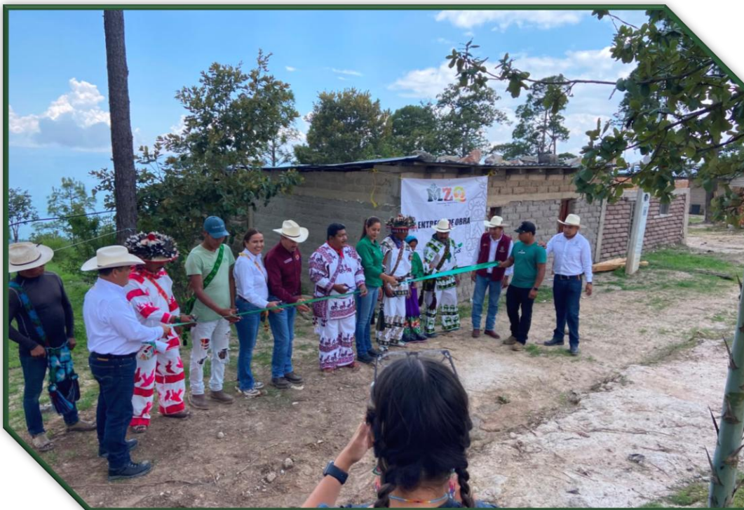
Rehabilitación del Sistema de Agua Potable en la localidad de Mesa de las Torresillas.
