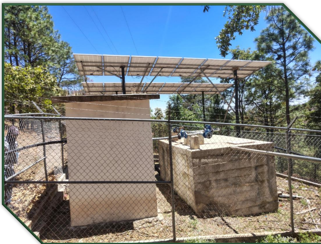
Rehabilitación del Sistema de Agua Potable en la localidad de Buena Vista.
