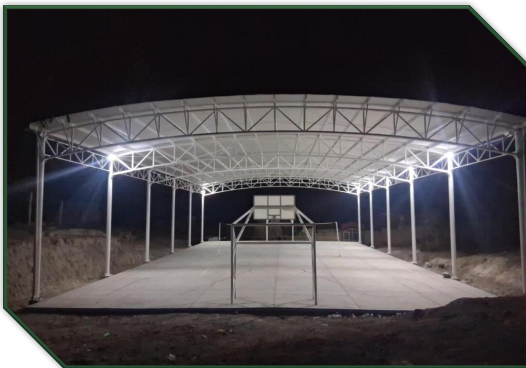
Construcción de cancha y domo en Las Cruces Chalchihuitillo.
