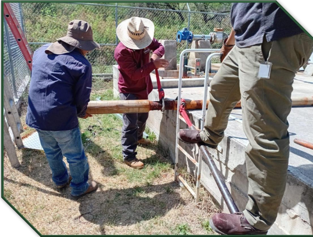
Reparación de bomba sumergibles El Limón.
