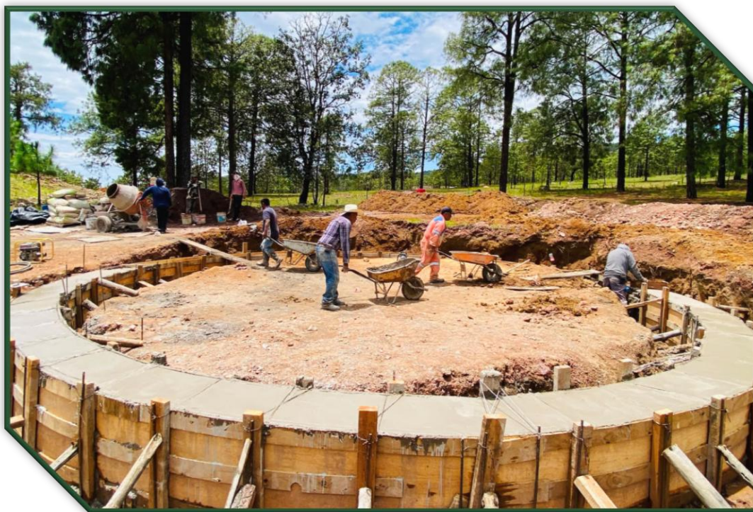
Construcción de sistema de agua potable con mega tanque en La Guajolota.
