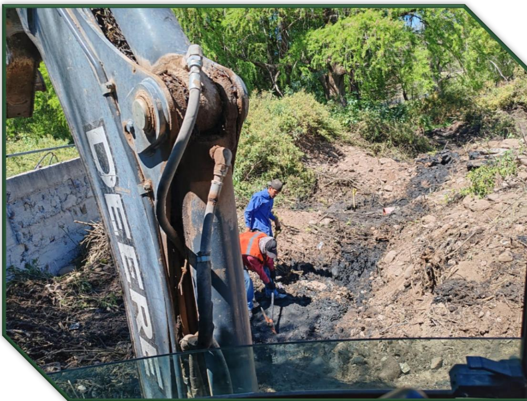
Desazolve de pozo de visita del río.
