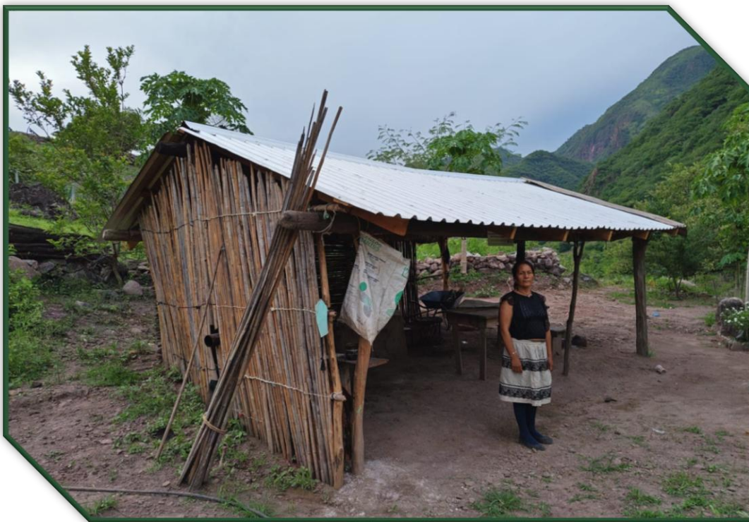
Construcción de techo firme con lámina galvanizada en San Pedro de Xicoras.
