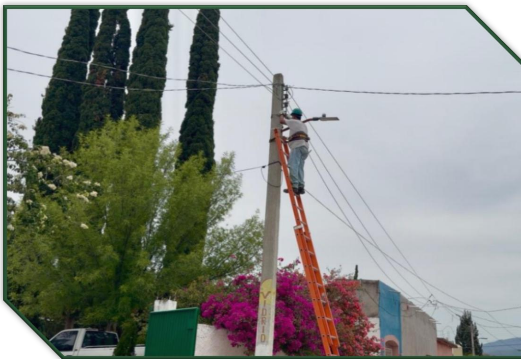
Reparación de lámparas de alumbrado público.
