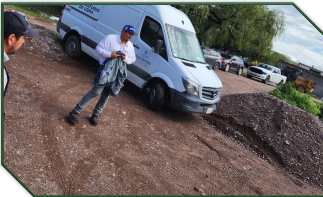
Pavimentación de la Calle Hidalgo en San Francisco del Mezquital.
