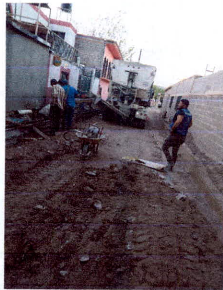
COLOCACION DE MATERIAL PARA RECIBIR PAVIMENTO
