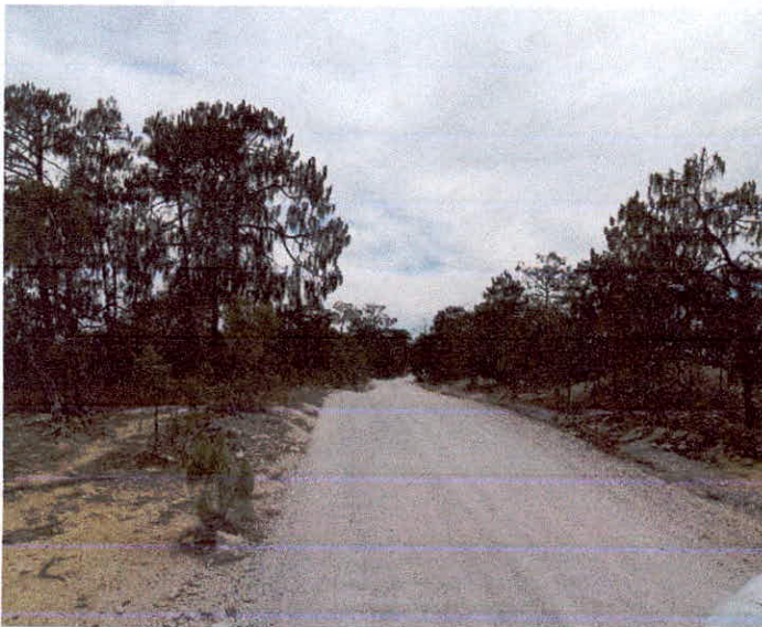
REVESTIMIENTO DE CAMINO CON MATERIAL DE BANCO
