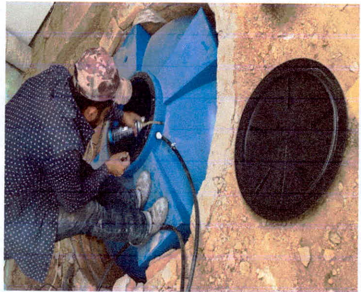
SUMINISTRO E INSTALACIÓN DE CISTERNA
