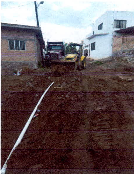
COLOCACIÓN DE TUBERÍA
