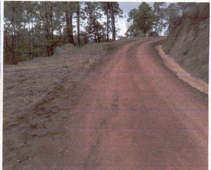
REVESTIMIENTO DE CAMINO CON MATERIAL DE BANCO
