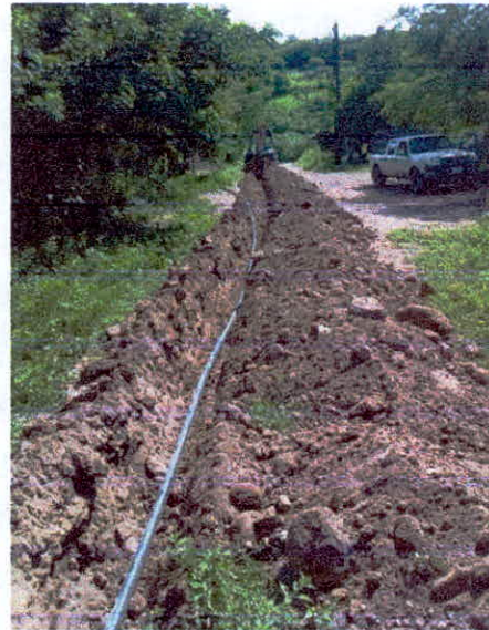
SUMINISTRO Y COLOCACION DE TUBERÍA DE POLIETILENO DE ALTA DENSIDAD
