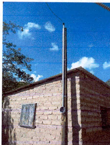
REHABILITACIÓN DE VIVIENDAS CON SUS SISTEMAS ELÉCTRICOS
