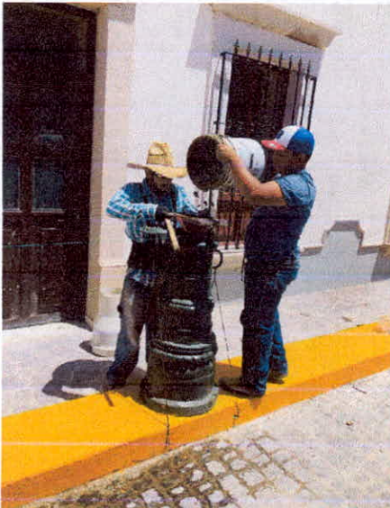
VACIADO DE CONCRETO
