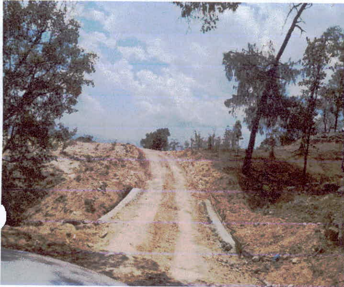
REVESTIMIENTO DE CAMINO CON MATERIAL DE BANCO
