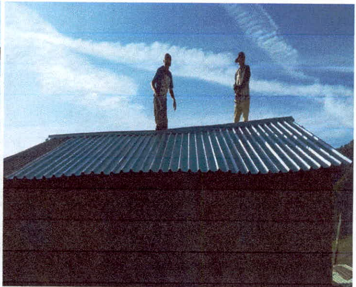
INSTALACIÓN DE LÁMINA GALVANIZADA
