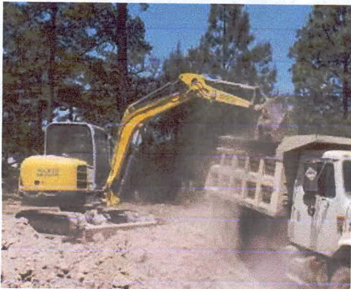
REVESTIMIENTO DE CAMINO CON MATERIAL DE BANCO
