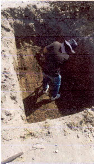
EXCAVACION PARA ZAPATA
