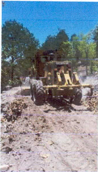
REVESTIMIENTO DE CAMINO CON MATERIAL DE BANCO
