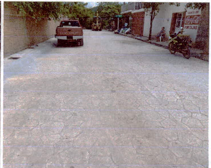
ACABADO DE PAVIMENTO HIDRAULICO CON ACABADO ESTAMPADO
