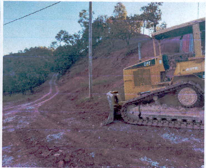
REVESTIMIENTO DE CAMINO CON MATERIAL DE BANCO
