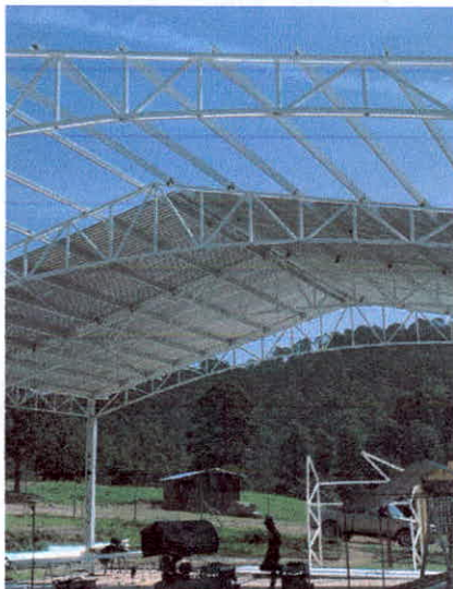
COLOCACIÓN DE LAMINA
