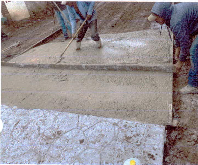
VACIADO DE CONCRETO
