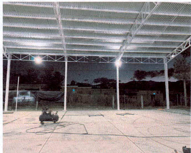
CONSTRUCCIÓN DE DOMO
