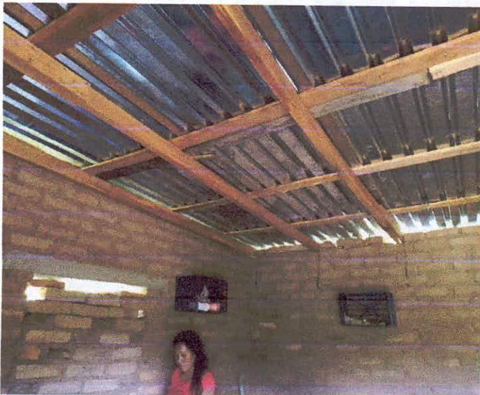
INSTALACIÓN DE LÁMINA GALVANIZADA
