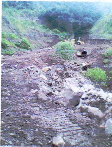
REVESTIMIENTO DE CAMINO CON MATERIAL DE BANCO
