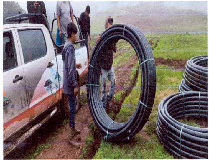
SUMINISTRO DE TUBERÍA DE POLIETILENO DE ALTA DENSIDAD
