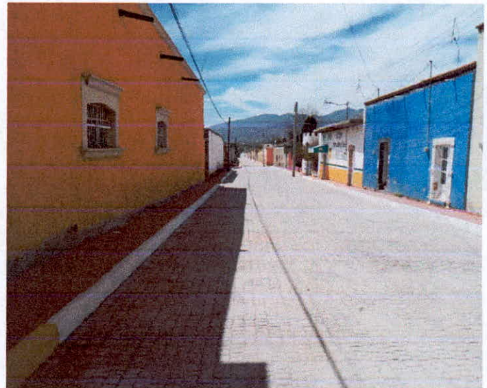
ACABADO DE PAVIMENTO HIDRAULICO TIPO ESTAMPADO
