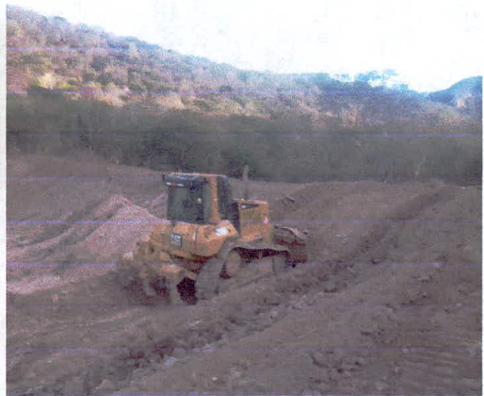
CONSTRUCCIÓN DE BORDOS DE ABREVADEERO CON EQUIPO MECÁNICO (TRACTOR DE ORUGAS)
