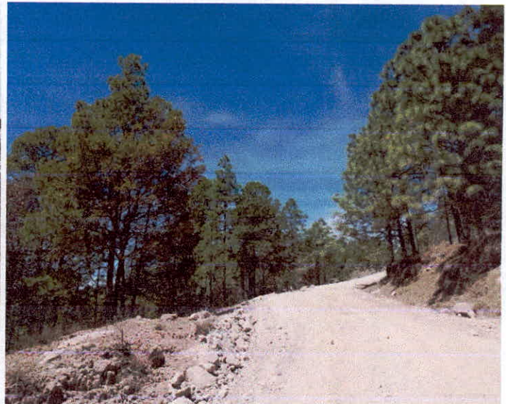
REVESTIMIENTO DE CAMINO CON MATERIAL DE BANCO
