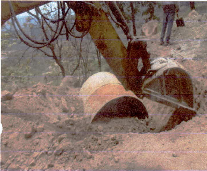
REVESTIMIENTO DE CAMINO CON MATERIAL DE BANCO
