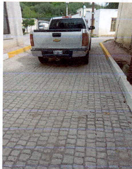
ACABADO DE PAVIMENTO HIDRAULICO CON ACABADO ESTAMPADO
