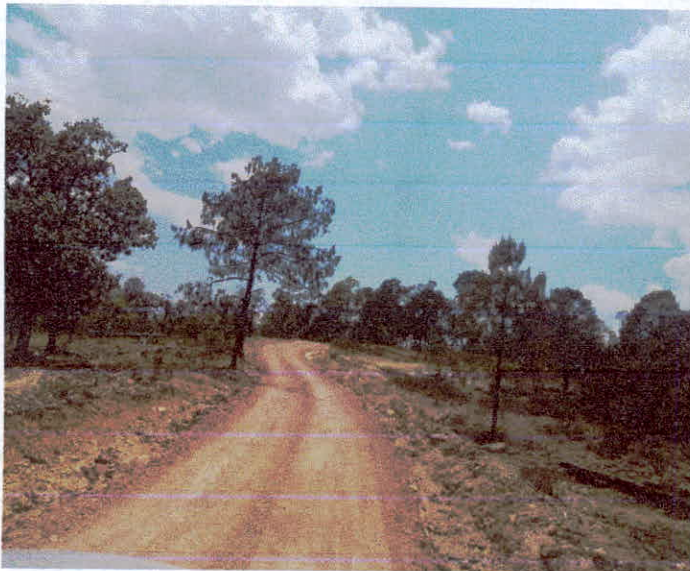
REVESTIMIENTO DE CAMINO CON MATERIAL DE BANCO
