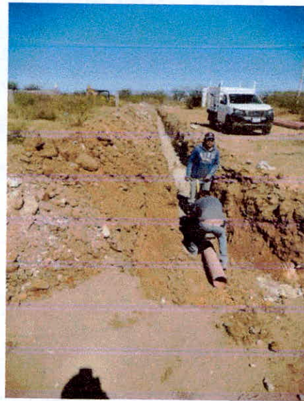
COLOCACIÓN DE TUBERÍA
