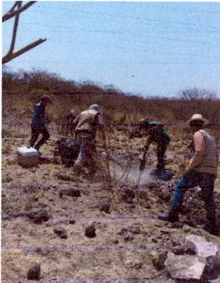
EXCAVACIÓN DE ZANJA PARA RECIBIR TUBERÍA
