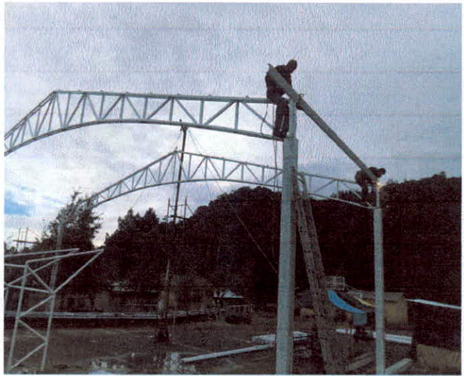
COLOCACIÓN DE CABRILLAS
