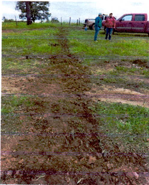
RELLNO DE ZANJA
