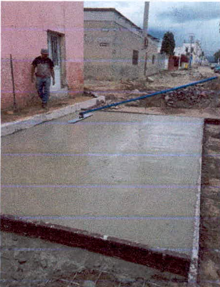
ELABORACION DE PAVIMENTO CONCRETO Premezclado
