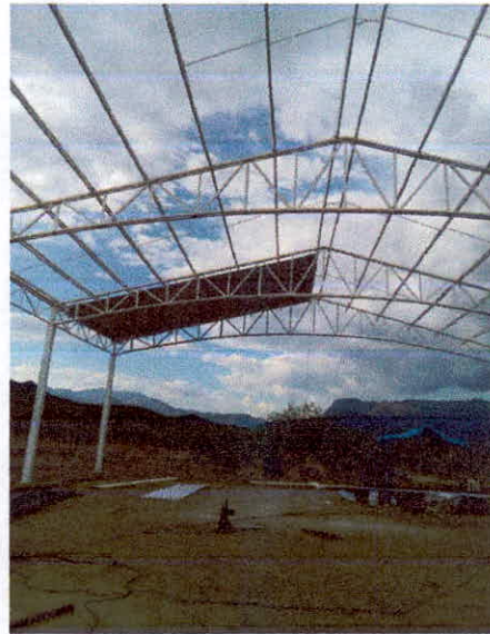
CONSTRUCCIÓN DE DOMO
