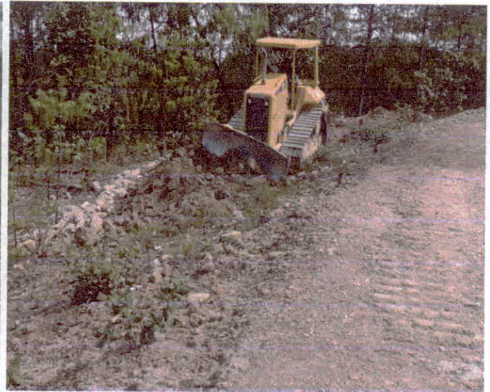
REVESTIMIENTO DE CAMINO CON MATERIAL DE BANCO
