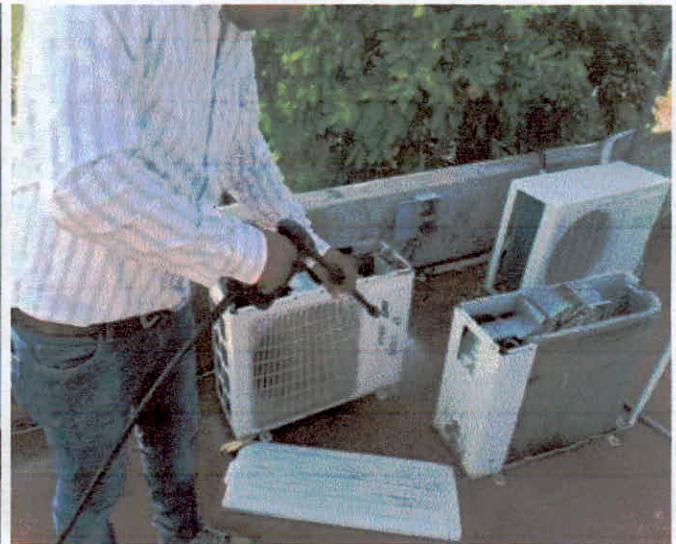
MANTENIMIENTO DE AIRES ACONDICIONADOS
