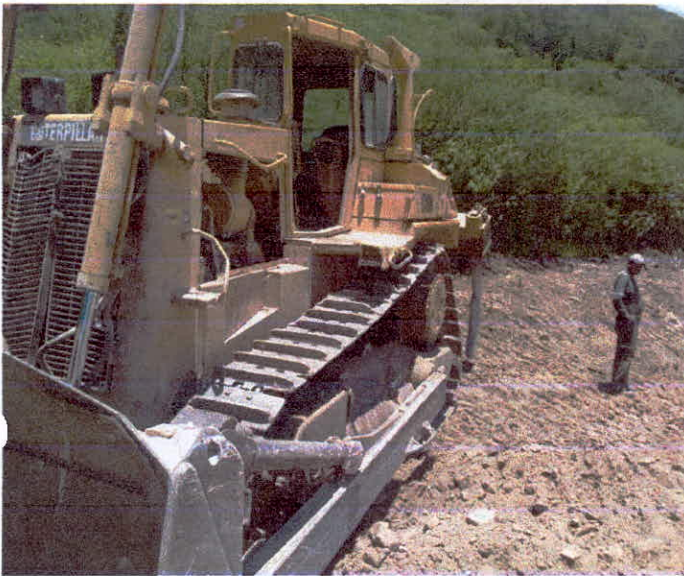
CONSTRUCCIÓN DE BORDOS DE ABREVADEERO CON EQUIPO MECÁNICO (TRACTOR DE ORUGAS)
