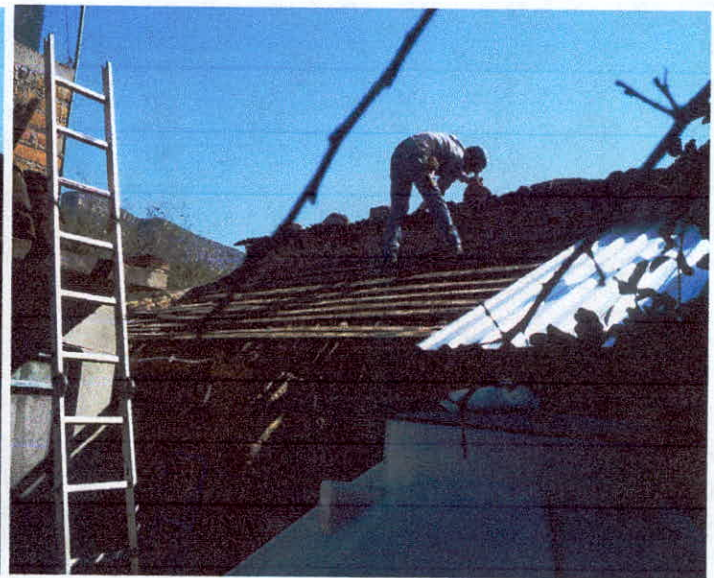
INSTALACIÓN DE LÁMINA GALVANIZADA
