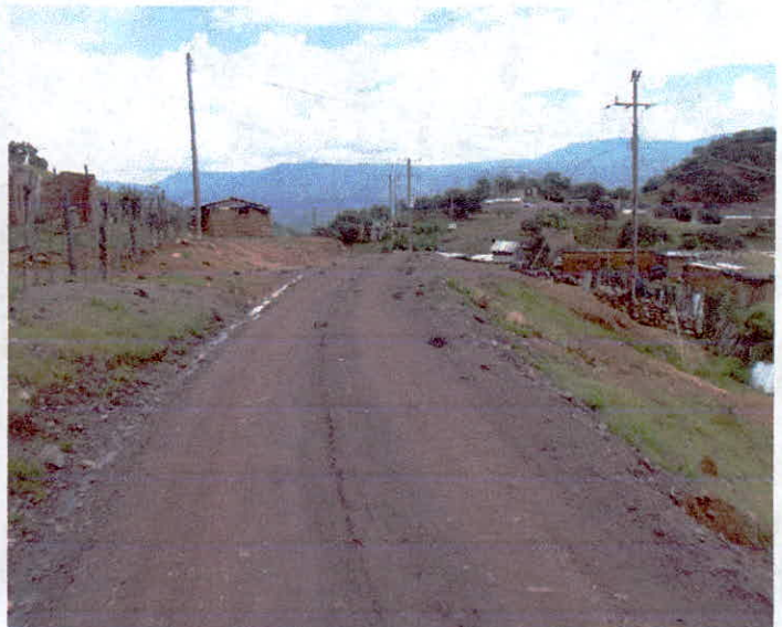
REVESTIMIENTO DE CAMINO CON MATERIAL DE BANCO
