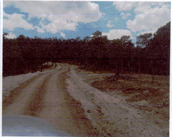
REVESTIMIENTO DE CAMINO CON MATERIAL DE BANCO
