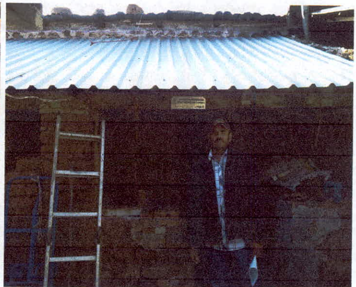
INSTALACIÓN DE LÁMINA GALVANIZADA
