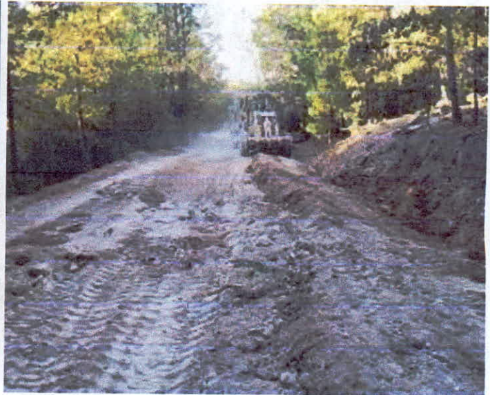
REVESTIMIENTO DE CAMINO CON MATERIAL DE BANCO
