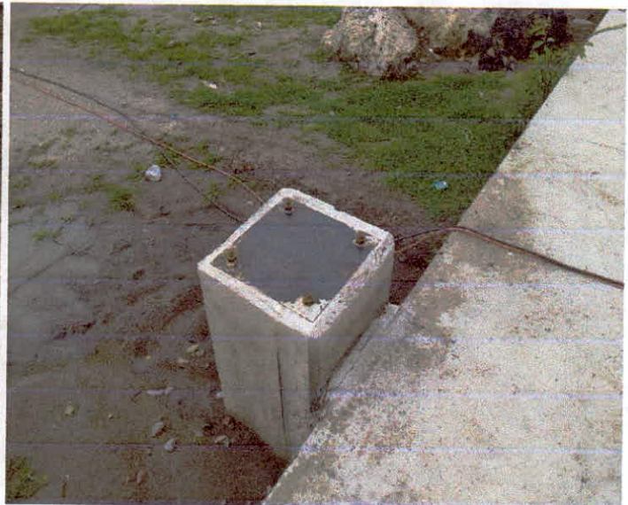
CONSTRUCCIÓN DE DOMO
