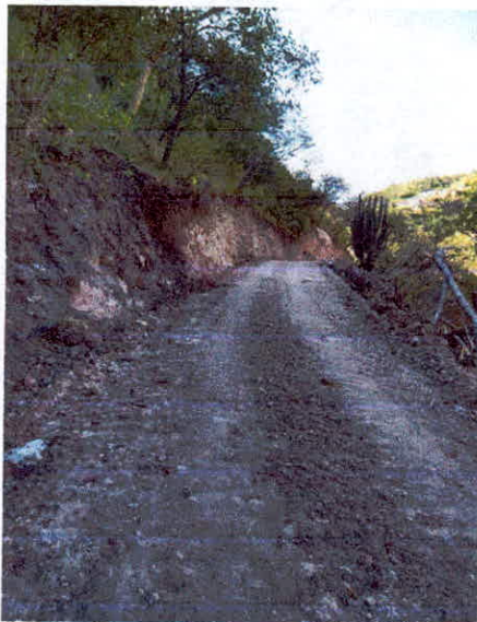
REVESTIMIENTO DE CAMINO CON MATERIAL DE BANCO
