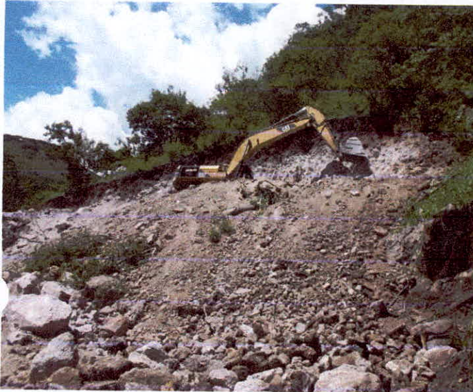
REVESTIMIENTO DE CAMINO CON MATERIAL DE BANCO
