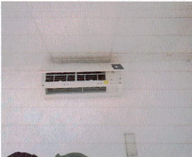
INSTALACIÓN DE AIRES ACONDICIONADOS
