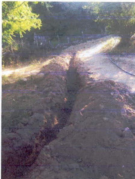
EXCAVACIÓN DE ZANJA PARA RECIBIR TUBERÍA
