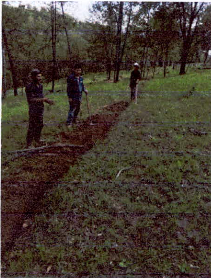
EXCAVACIÓN DE ZANJA PARA RECIBIR TUBERÍA
