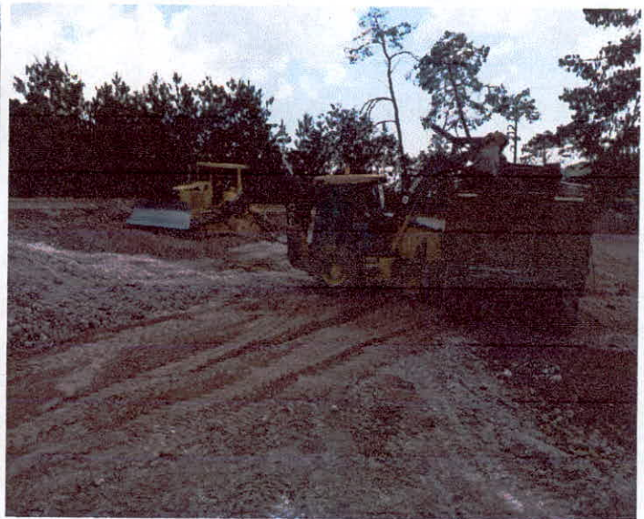
REVESTIMIENTO DE CAMINO CON MATERIAL DE BANCO
