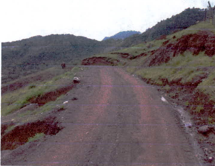
REVESTIMIENTO DE CAMINO CON MATERIAL DE BANCO
