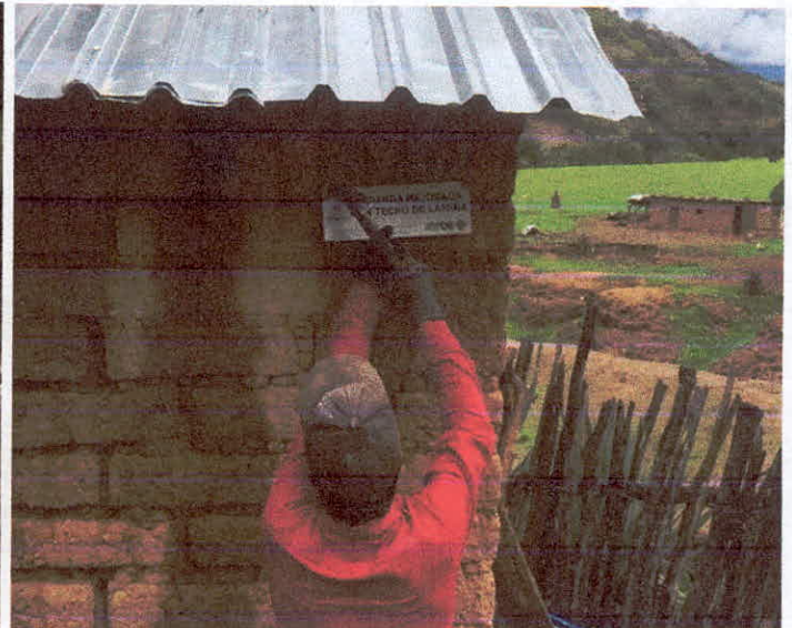
INSTALACIÓN DE LÁMINA GALVANIZADA
