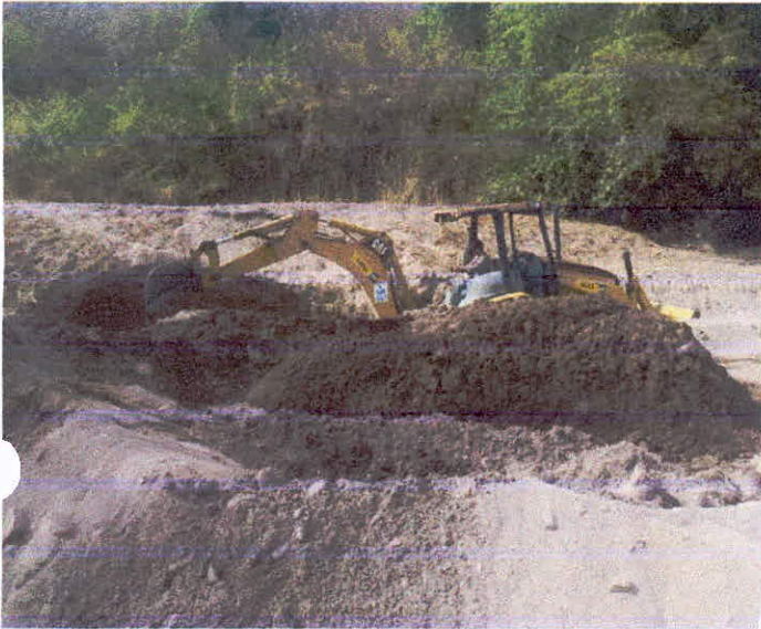
EXCAVACIÓN DE ZANJA PARA RECIBIR TUBERÍA
