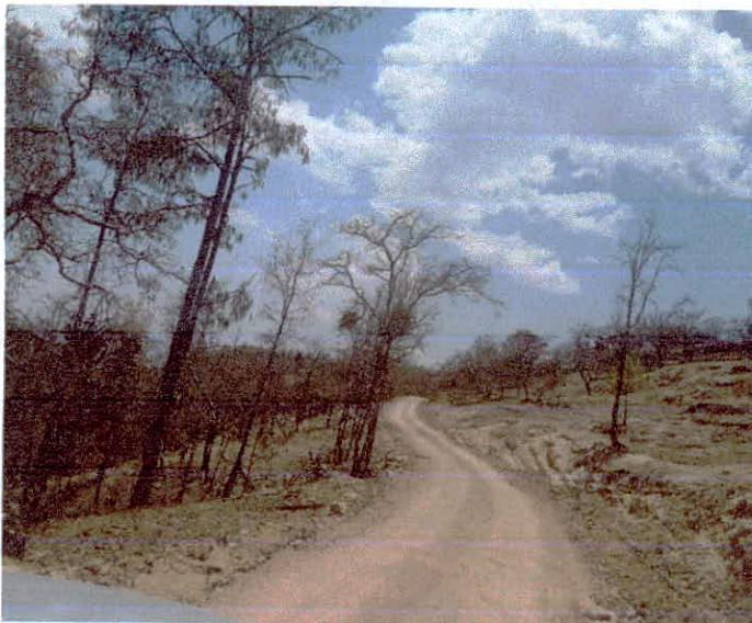
REVESTIMIENTO DE CAMINO CON MATERIAL DE BANCO
