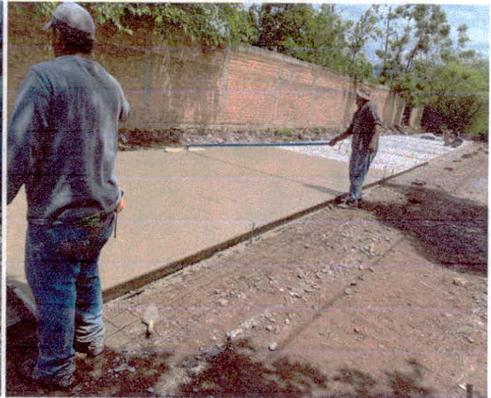
VACIADO DE CONCRETO
