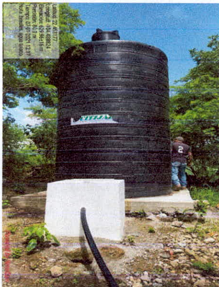
INSTALACIÓN DE TINACO
