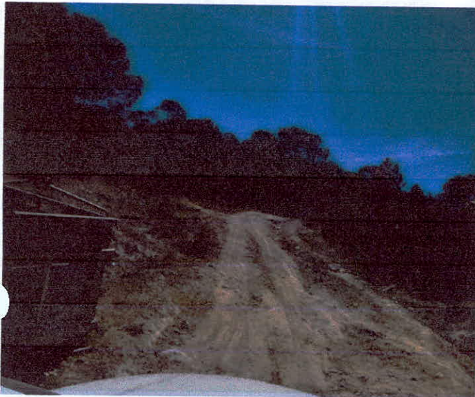
REVESTIMIENTO DE CAMINO CON MATERIAL DE BANCO
