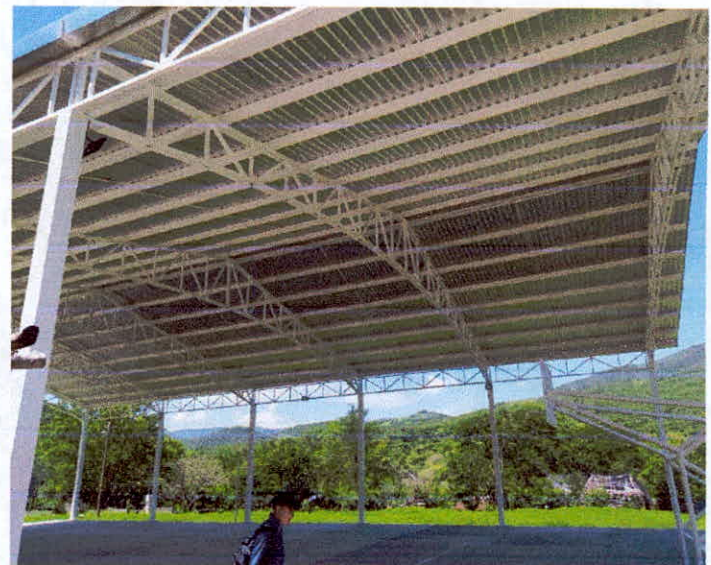
CONSTRUCCIÓN DE DOMO
