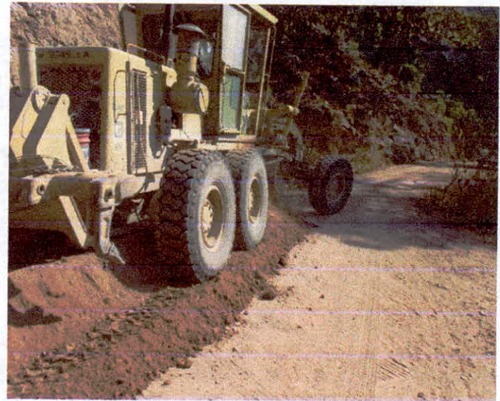
REVESTIMIENTO DE CAMINO CON MATERIAL DE BANCO
