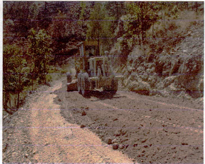
REVESTIMIENTO DE CAMINO CON MATERIAL DE BANCO
