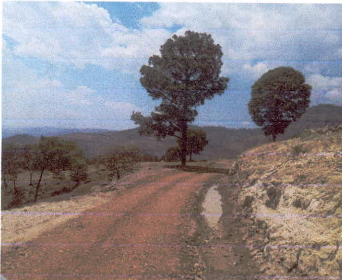
REVESTIMIENTO DE CAMINO CON MATERIAL DE BANCO
