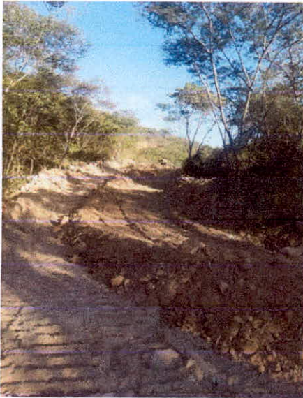
REVESTIMIENTO DE CAMINO CON MATERIAL DE BANCO
