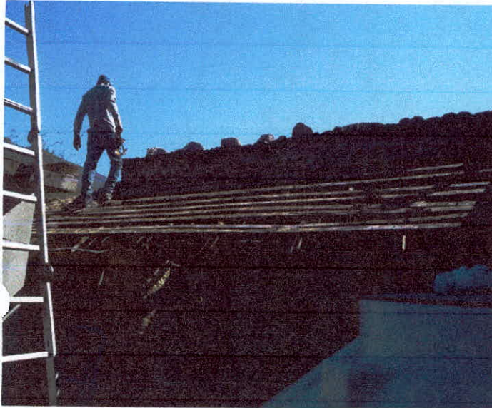
INSTALACIÓN DE LÁMINA GALVANIZADA
