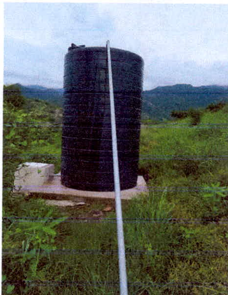
INSTALACIÓN DE TINACO
