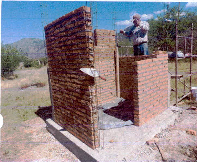
MURO DE TABIQUE ROJO RECOCIDO
