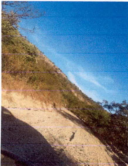
REVESTIMIENTO DE CAMINO CON MATERIAL DE BANCO
