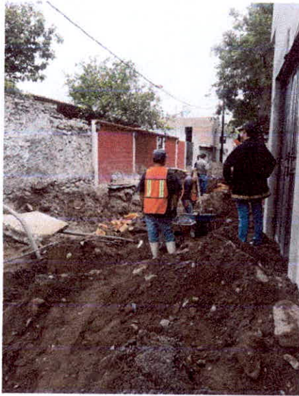
COLOCACION DE MATERIAL PARA RECIBIR PAVIMENTO
