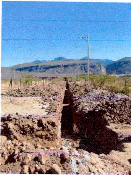
EXCAVACIÓN DE ZANJA PARA RECIBIR TUBERÍA
