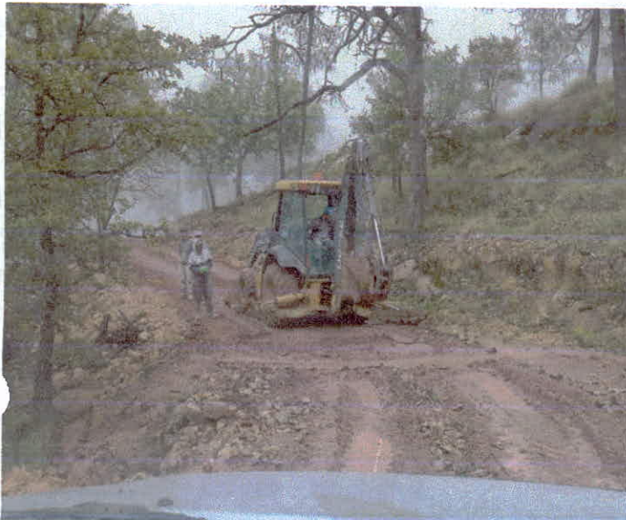
REVESTIMIENTO DE CAMINO CON MATERIAL DE BANCO
