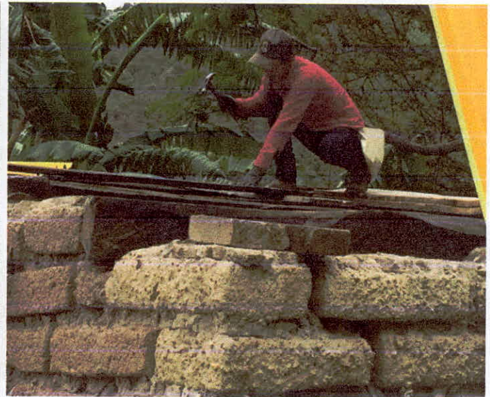
INSTALACIÓN DE LÁMINA GALVANIZADA
