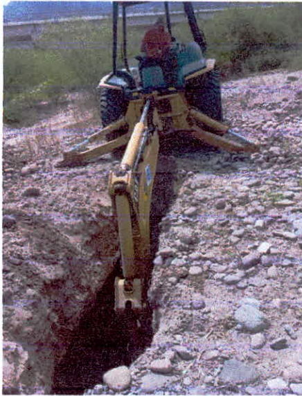
EXCAVACIÓN DE ZANJA PARA RECIBIR TUBERÍA
