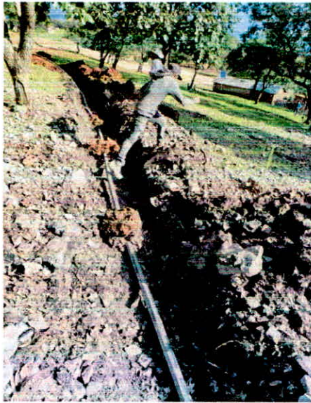
EXCAVACIÓN DE ZANJA PARA RECIBIR TUBERÍA
