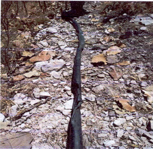
RETIRO DE MATERIAL EXISTENTE EN MALAS CONDICIONES
