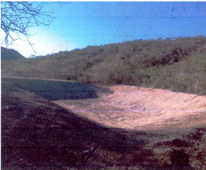
CONSTRUCCIÓN DE BORDOS DE ABREVADEERO CON EQUIPO MECÁNICO (TRACTOR DE ORUGAS)
