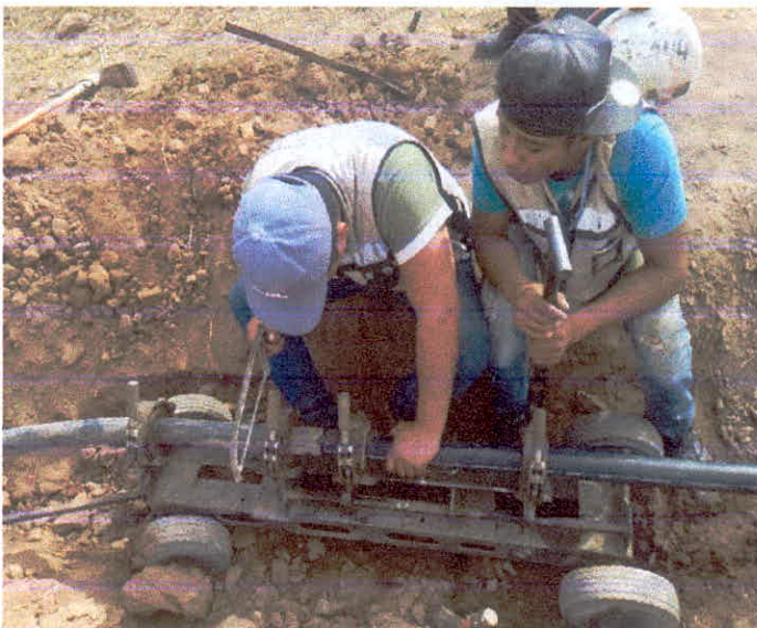
TERMOFUSIÓN DE TUBERIA
