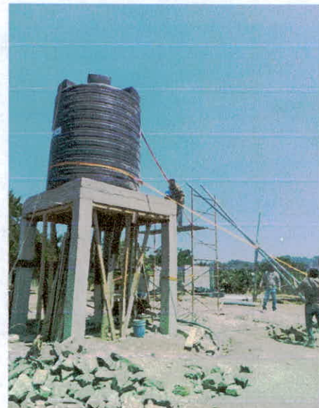
INSTALACIÓN DE TINACO
