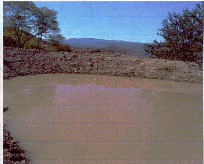
CONSTRUCCIÓN DE BORDOS DE ABREVADEERO CON EQUIPO MECÁNICO (TRACTOR DE ORUGAS)
