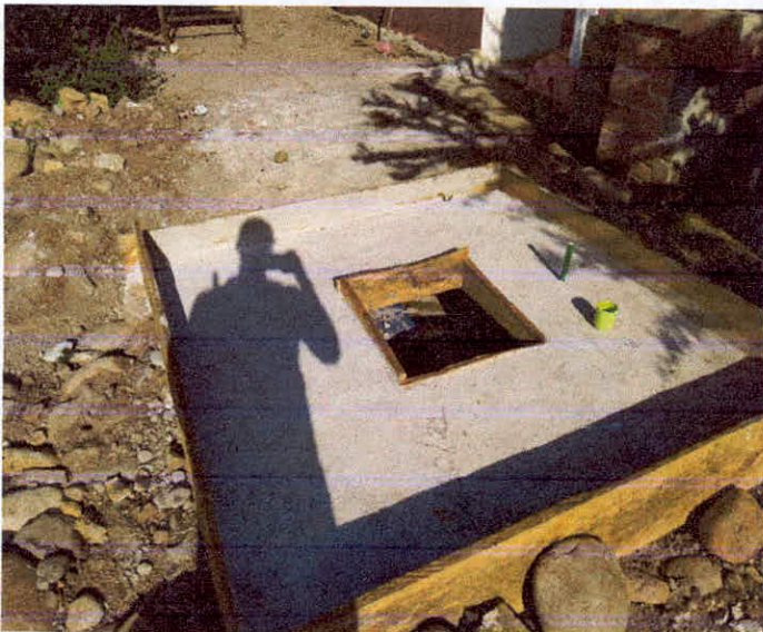
PLANCHA DE CONCRETO
