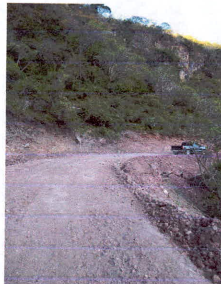
REVESTIMIENTO DE CAMINO CON MATERIAL DE BANCO
