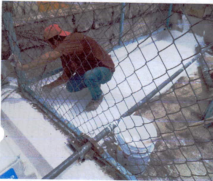
APLICACIÓN DE IMPERMEABILIZANTE
