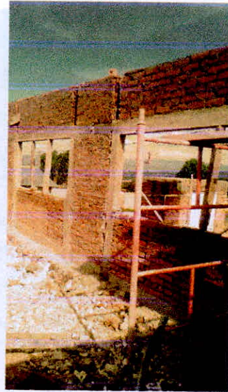
MURO DE TABIQUE ROJO RECOCIDO
