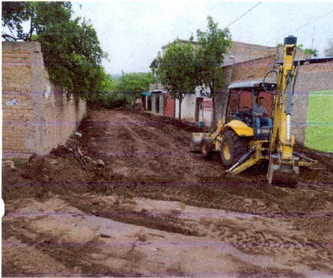
EXCAVACIÓN DE ZANJA PARA RECIBIR TUBERÍA
