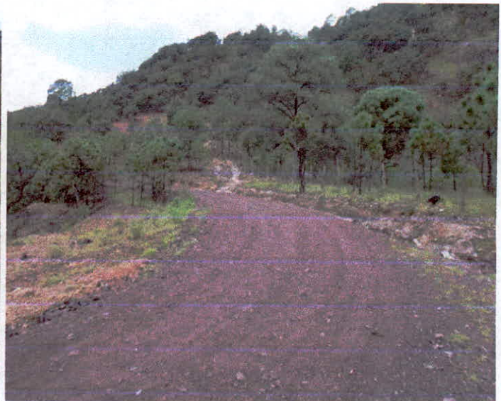
REVESTIMIENTO DE CAMINO CON MATERIAL DE BANCO
