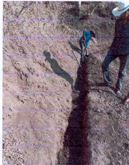
EXCAVACIÓN DE ZANJA PARA RECIBIR TUBERÍA
