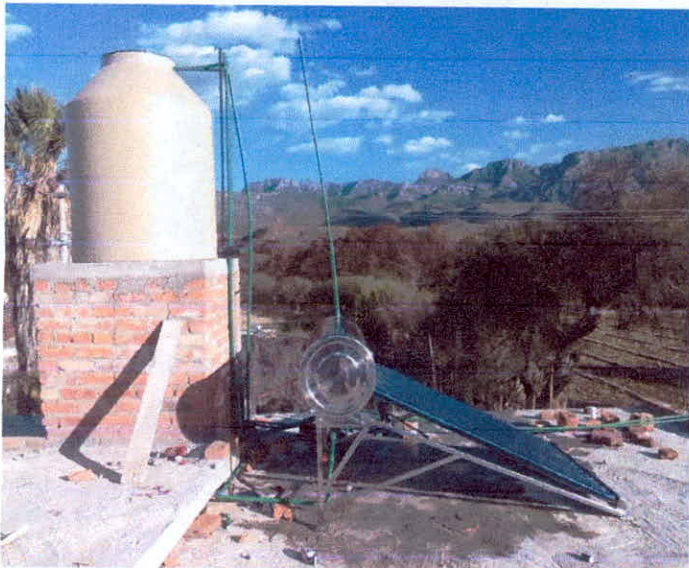
INSTALACIÓN DE CALENTADORES SOLARES
