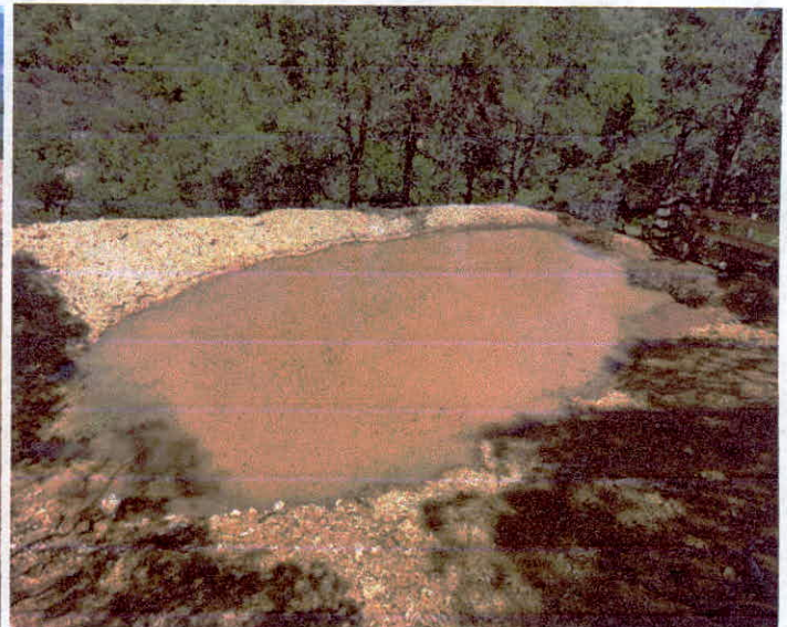
CONSTRUCCIÓN DE BORDOS DE ABREVADEERO CON EQUIPO MECÁNICO (TRACTOR DE ORUGAS)
