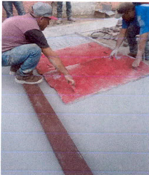
ACABADO DE PAVIMENTO HIDRAULICO CON ACABADO ESTAMPADO
