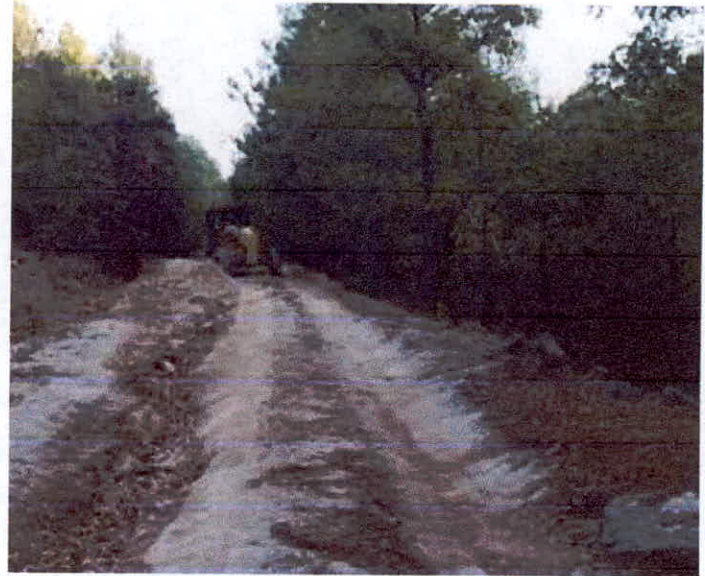
REVESTIMIENTO DE CAMINO CON MATERIAL DE BANCO
