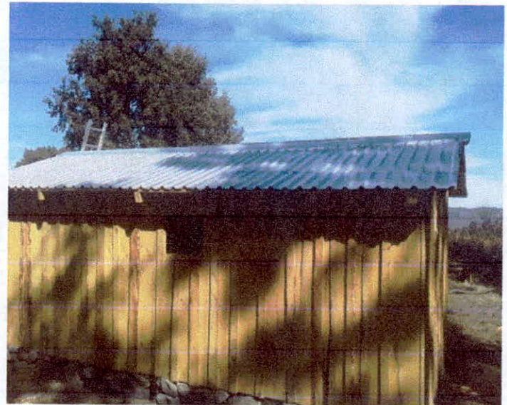
INSTALACIÓN DE LÁMINA GALVANIZADA
