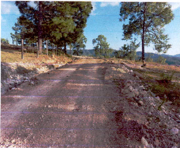
REVESTIMIENTO DE CAMINO CON MATERIAL DE BANCO
