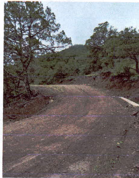
REVESTIMIENTO DE CAMINO CON MATERIAL DE BANCO Y OBRAS DE DRENAJE
