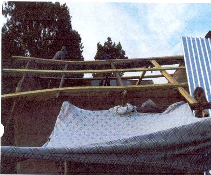
INSTALACIÓN DE LÁMINA GALVANIZADA
