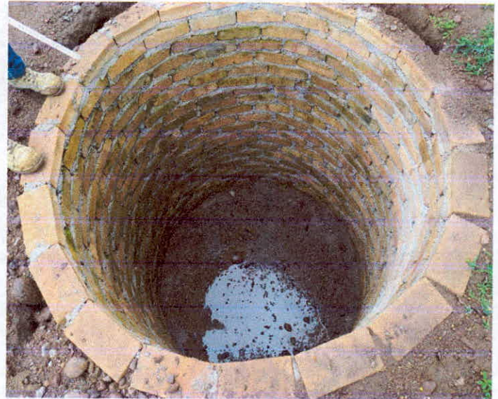
MURO DE TABIQUE ROJO PARA PROTECCIÓN DE CISTERNA
