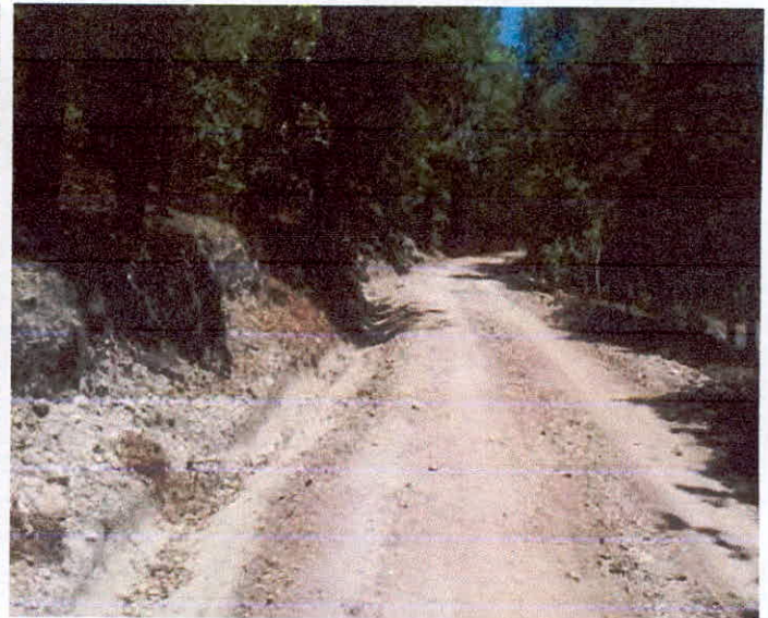
REVESTIMIENTO DE CAMINO CON MATERIAL DE BANCO
