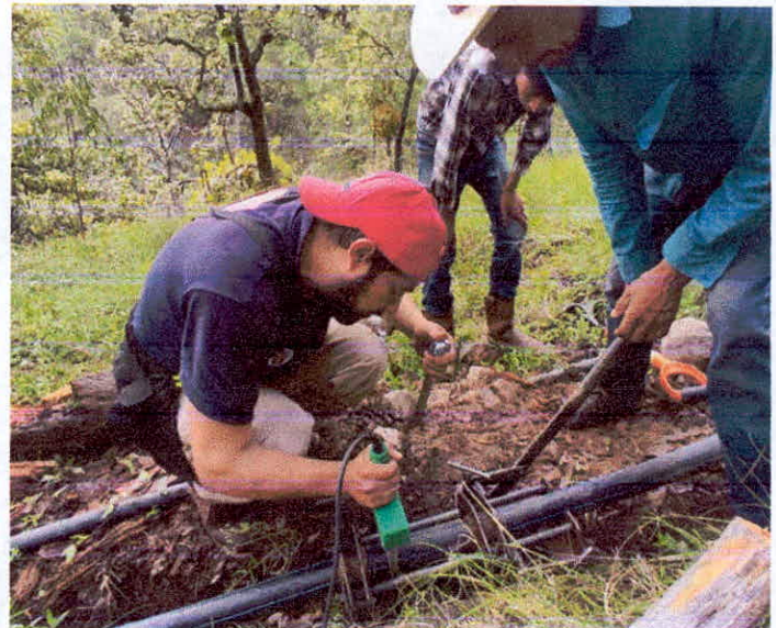
TERMOFUSION DE TUBERIA
