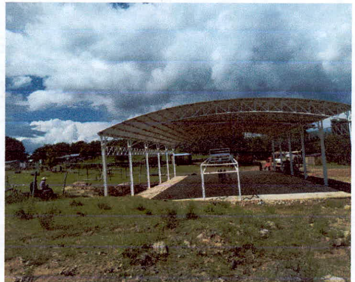
CONSTRUCCIÓN DE DOMO
