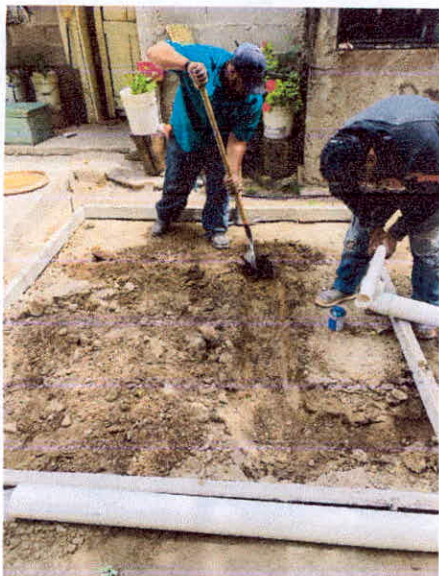
TRAZO, NIVELACIÓN Y EXCAVACIÓN
