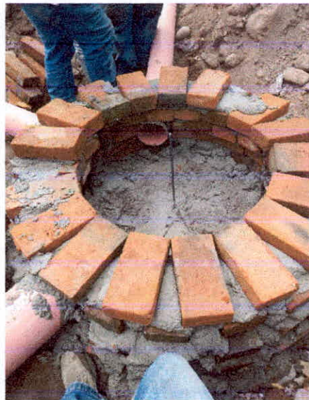
POZOS DE VISITA
