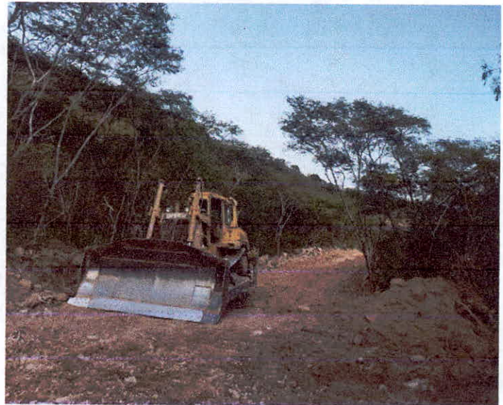
REVESTIMIENTO DE CAMINO CON MATERIAL DE BANCO
