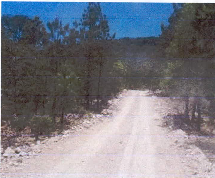
REVESTIMIENTO DE CAMINO CON MATERIAL DE BANCO
