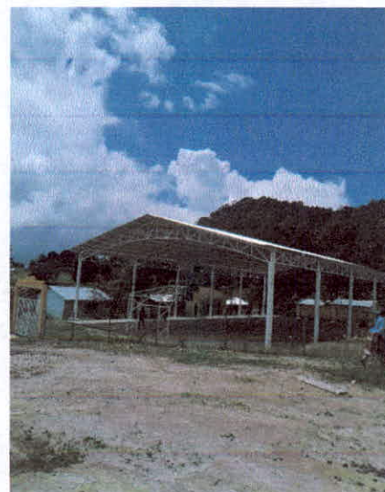
CONSTRUCCIÓN DE DOMO
