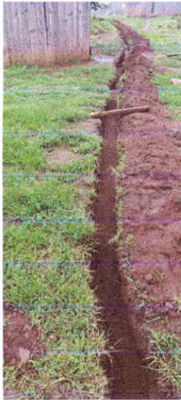
EXCAVACIÓN DE ZANJA PARA RECIBIR TUBERÍA
