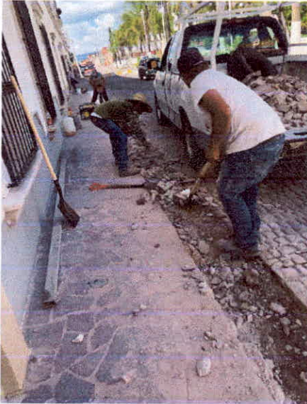
RETIRO DE MATERIAL EXISTENTE
