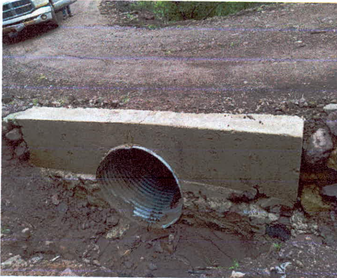
REVESTIMIENTO DE CAMINO CON MATERIAL DE BANCO Y OBRAS DE DRENAJE
