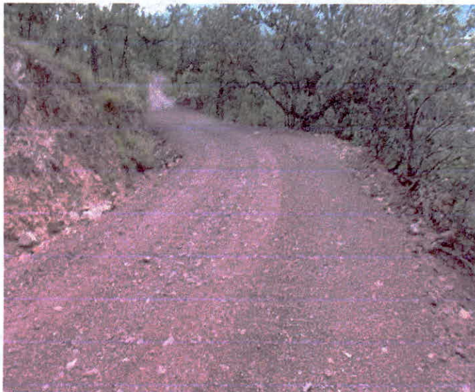
REVESTIMIENTO DE CAMINO CON MATERIAL DE BANCO
