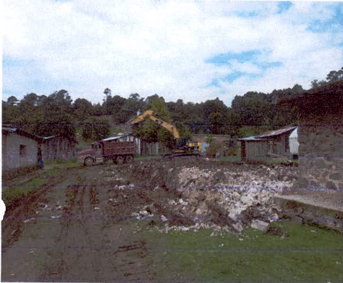
NIVELACION DE TERRENO
