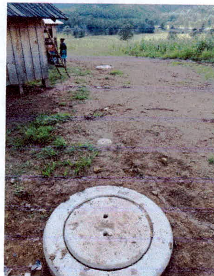
POZOS DE VISITA
