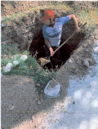
EXCAVACION PARA ZAPATA
