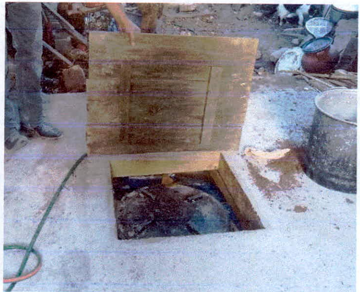
PLANCHA DE CONCRETO
