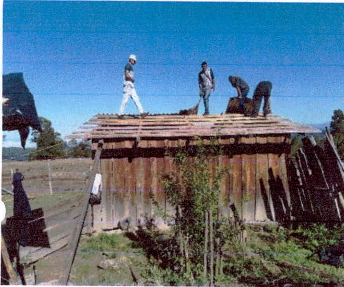
INSTALACIÓN DE LÁMINA GALVANIZADA
