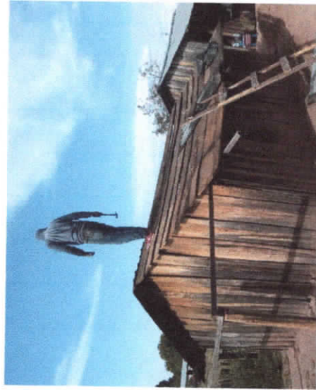
DETALLE COLOCACIÓN DE LÁMINA GALVANIZADA EN LOSA CON CAÍDA A DOS AGUAS
