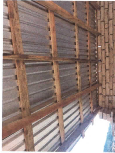
DETALLE COLOCACIÓN DE LÁMINA GALVANIZADA EN LOSA CON CAÍDA A DOS AGUAS
